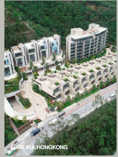
LINK KUI, HONGKONG
