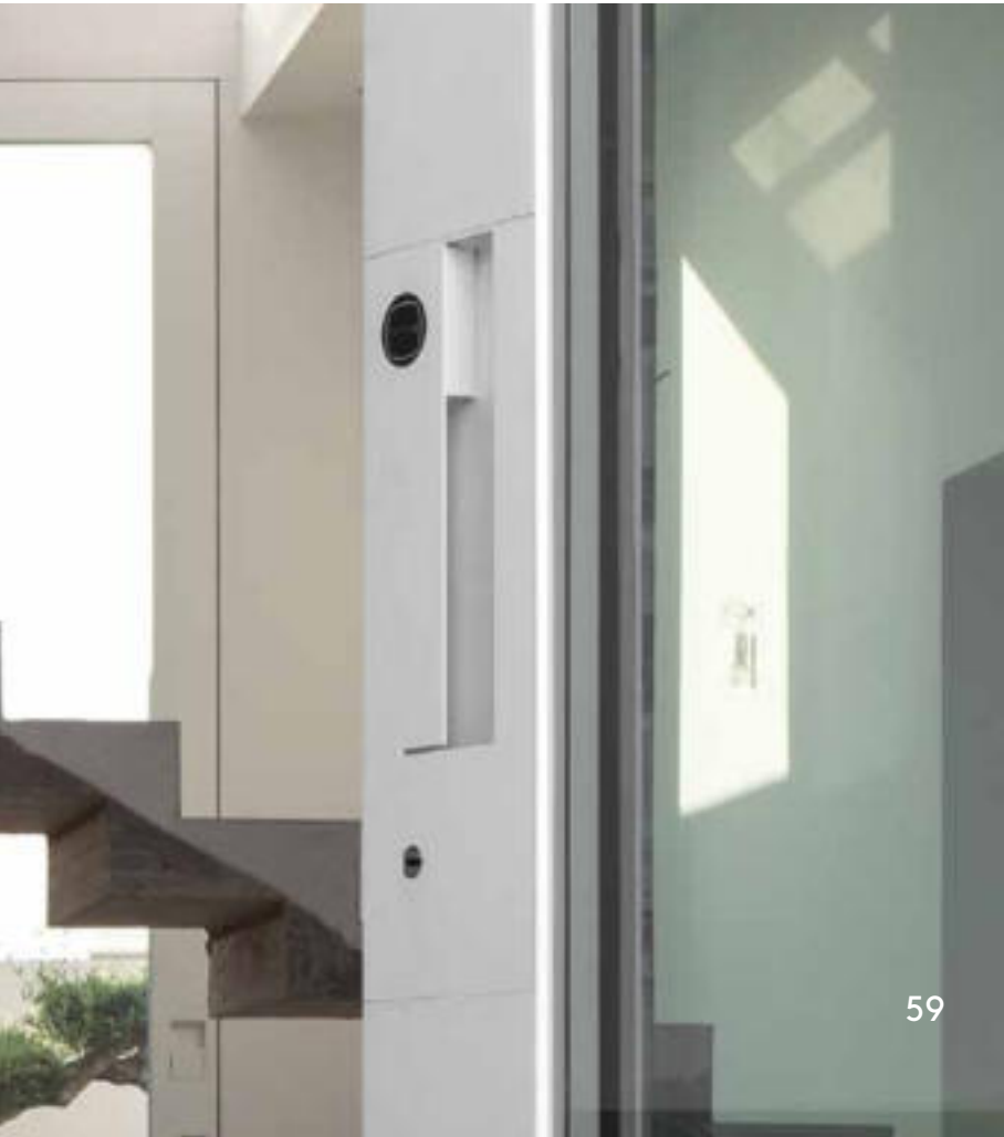
Maniglione esterno serratura Arckey e tastiera touch
