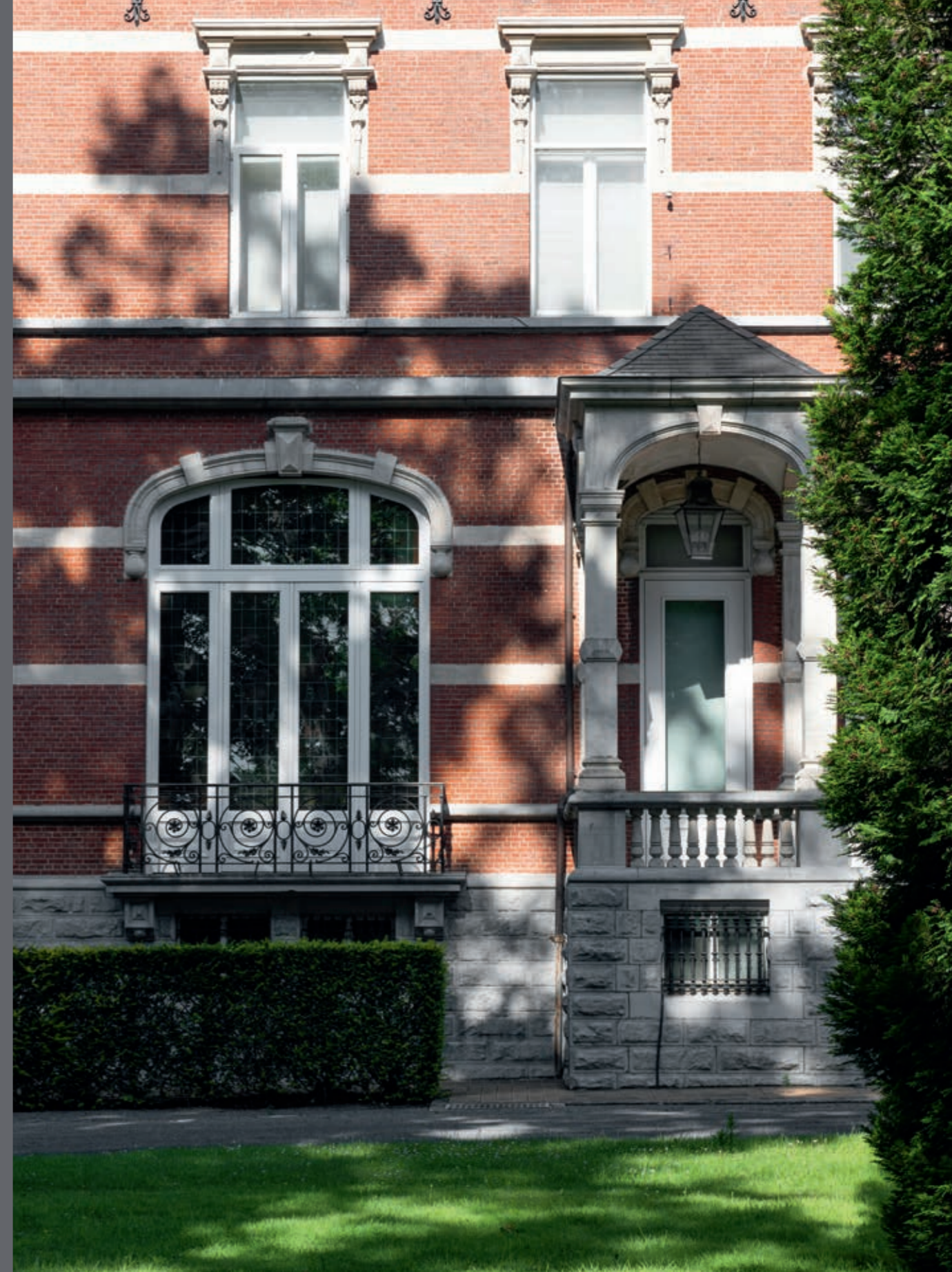
Esterno: Línea Massello Villa a disegno laccato RAL 9016 Interno: Línea Massello Villa a disegno in Okoumé 7 Sistema a 2 ante centrali con laterali fissi e soprauce ad arco a replica del serramento originale, recupero dei vetri artistici originali con accoppiamento a vetro blindato
