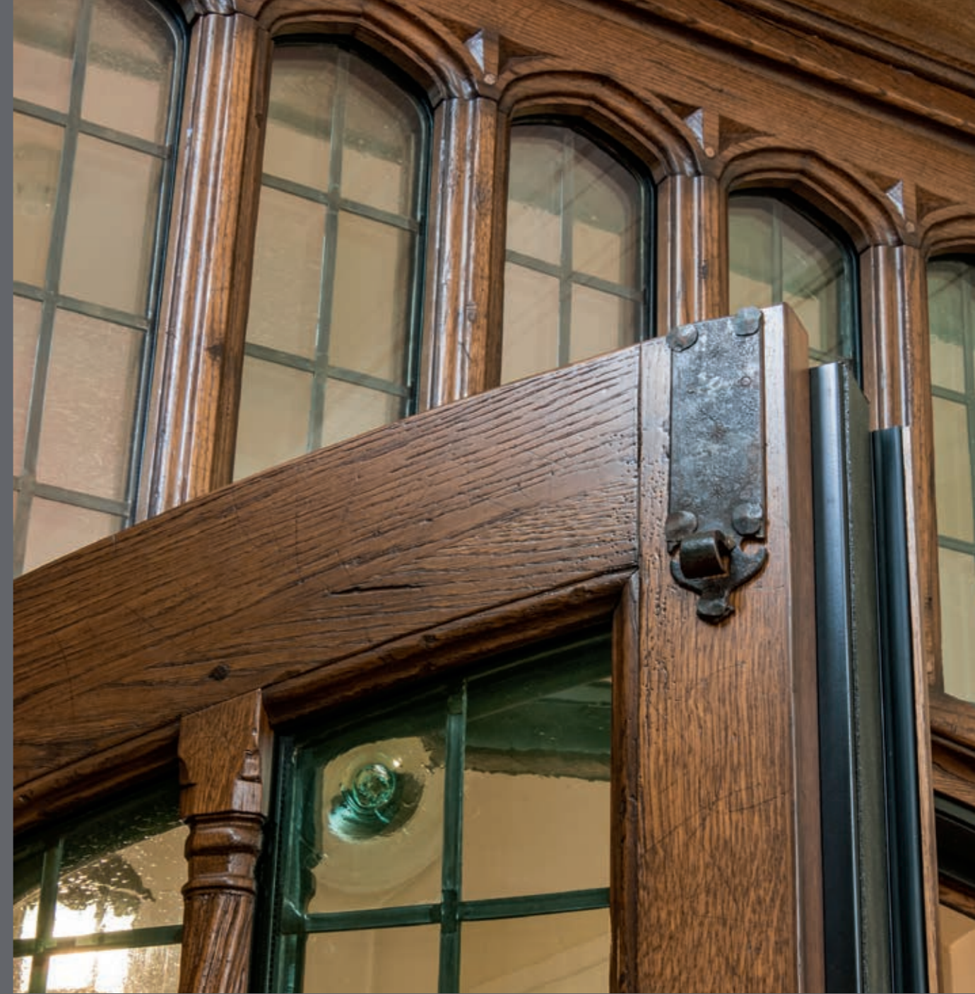
Esterno: Pannello a disegno in Rovere anticato a campione Interno: Pannello a disegno in Rovere anticato a campione Sistema a 2 anta ad arco a sesto acuto con soprauce rettangolare realizzato a disegno come replica del portone storico originale, recupero dei vetri decorativi artistici originali con accoppiamento a vetro blindato
