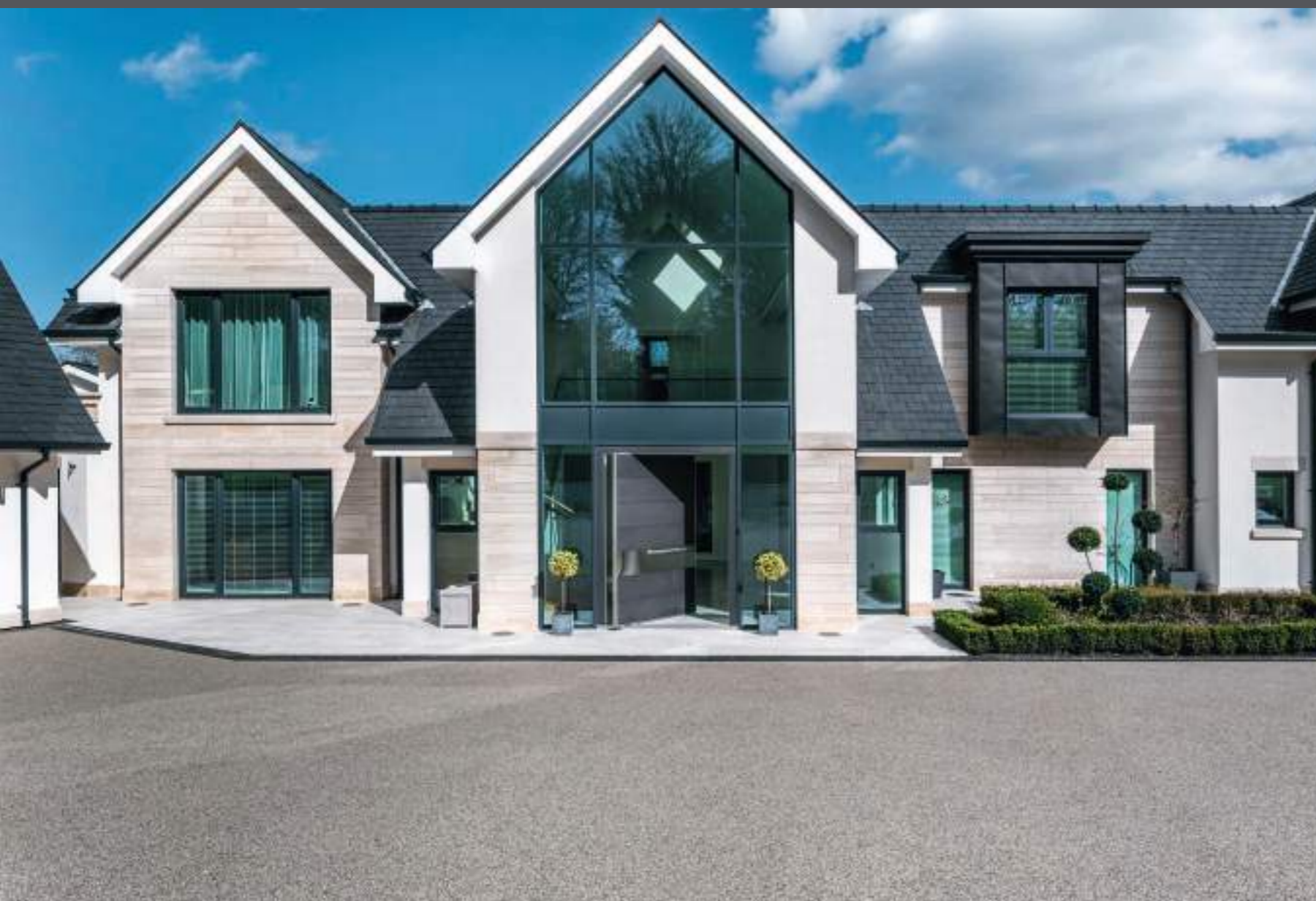
Esterno: Linea Portici a settori Rovere poro aperto a campione con settore in inox Interno: Linea Portici a disegno Laminam Bianco Statuario Venato con settori in inox Montaggio su facciata esistente
