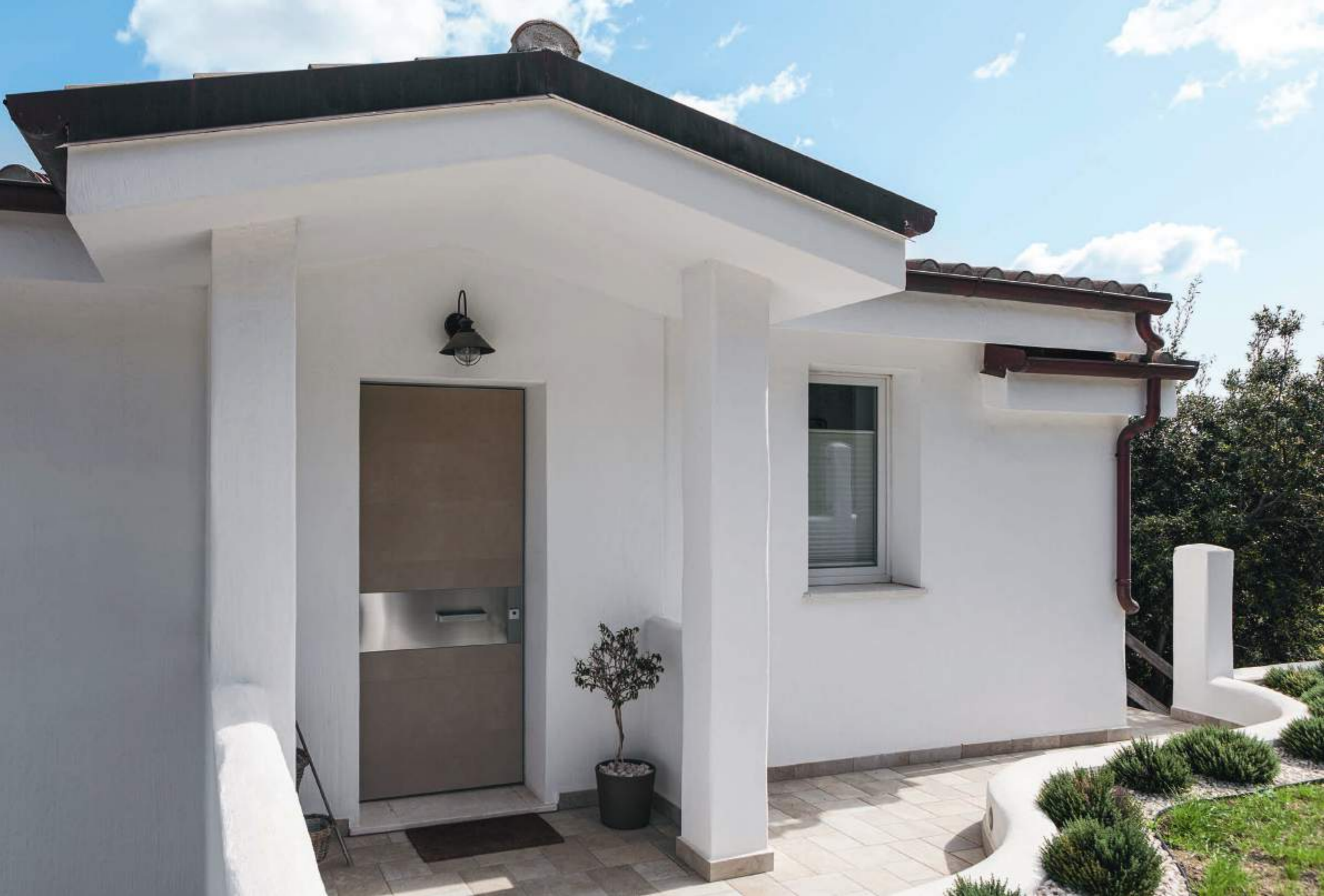
Esterno: Línea Tekno HTL a settori in Laminam Calce Grigio con settore in inox
