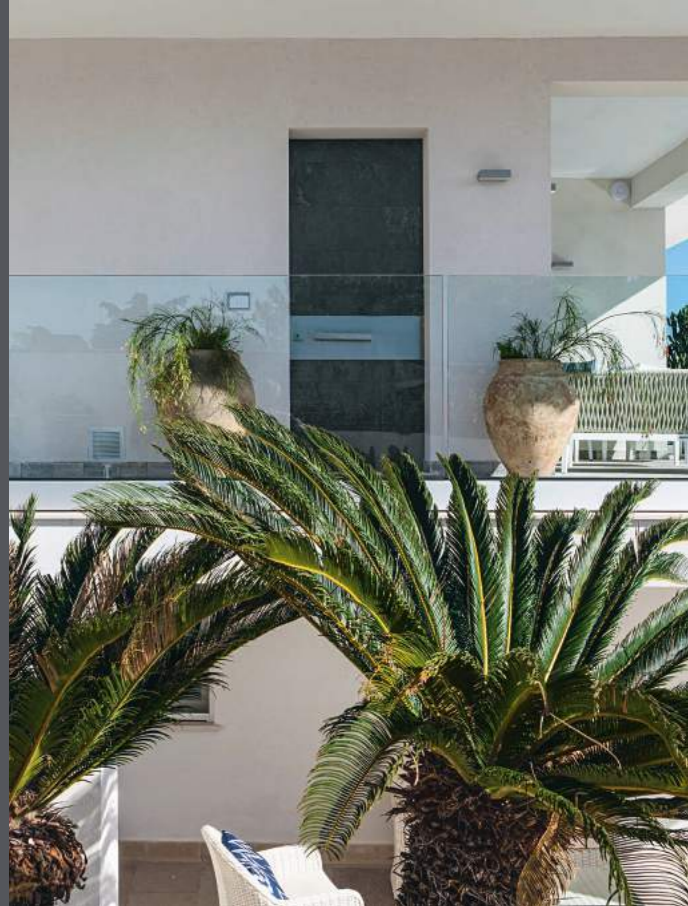
Esterno: Linea Tekno HTL a settori in Laminam CorTen Acciaio con settore in inox
