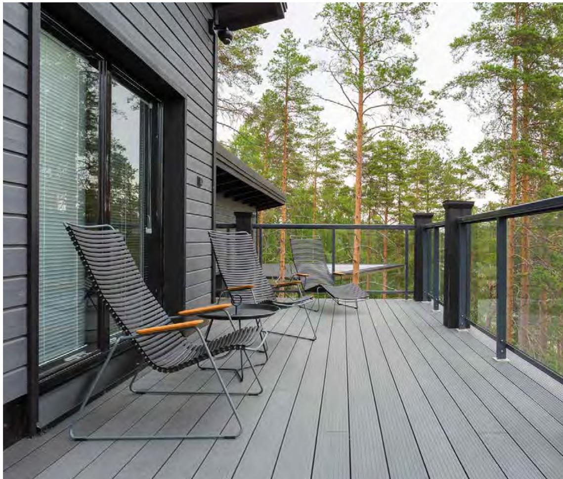
Techwood TD-212 Corà è tre volte la densità del pino e contiene più del 66% di fibra di legno termotrattato, il 20% di Polimero PP riciclato di alta qualità CIRCO® e il 14% di additivo colorato e catalizzatore.
