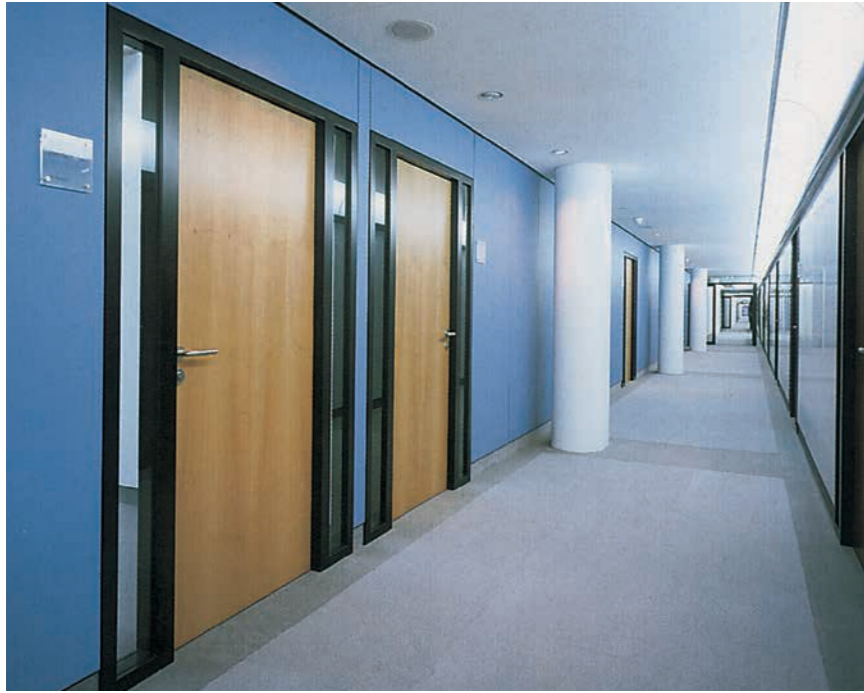
Edelstahlzarge bündig mit Türblatt und Mauer
